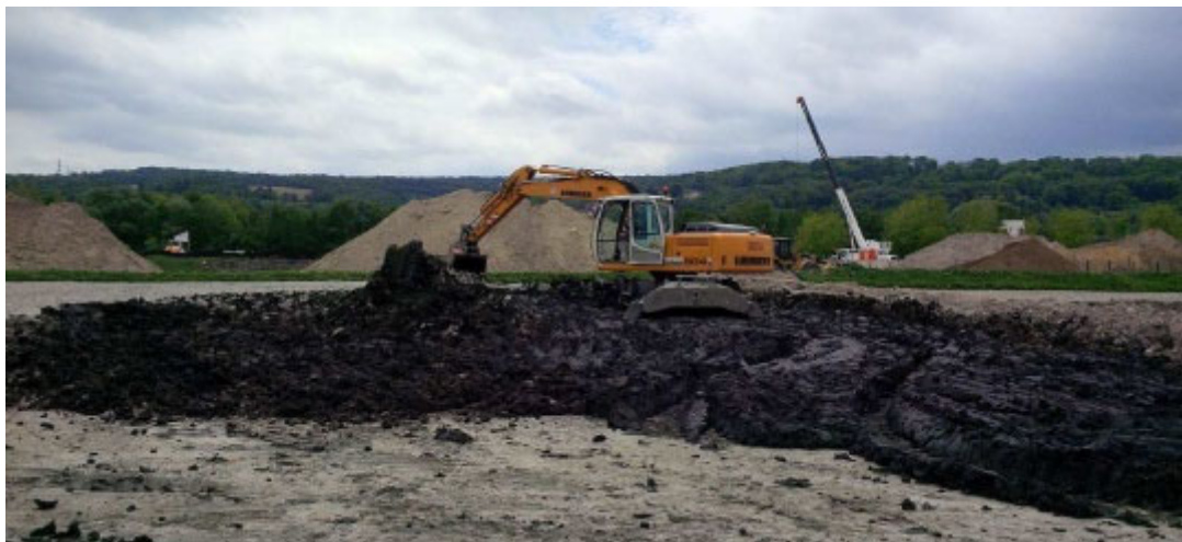
Opération de retournement des sédiments (ressuyage dynamique) – Site de Bruyère-sur-Oise
