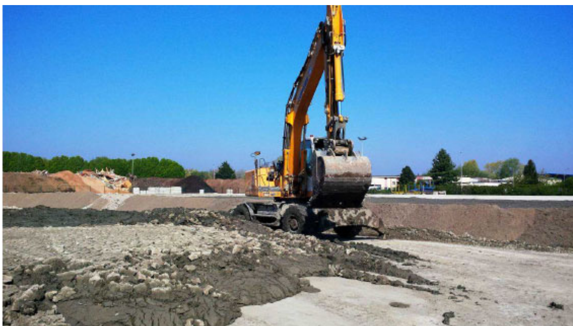
Opération de retournement des sédiments (ressuyage dynamique) – Site de Bruyère-sur-Oise
