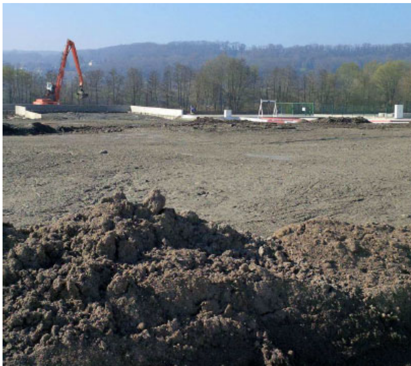
Vue sur les sédiments en cours de consolidation, avec l'opération de dépotage en arrière-plan sur le site de Bruyères-sur-Oise (60)
